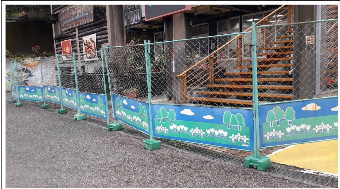
說明：學校工程設置安全圍籬
